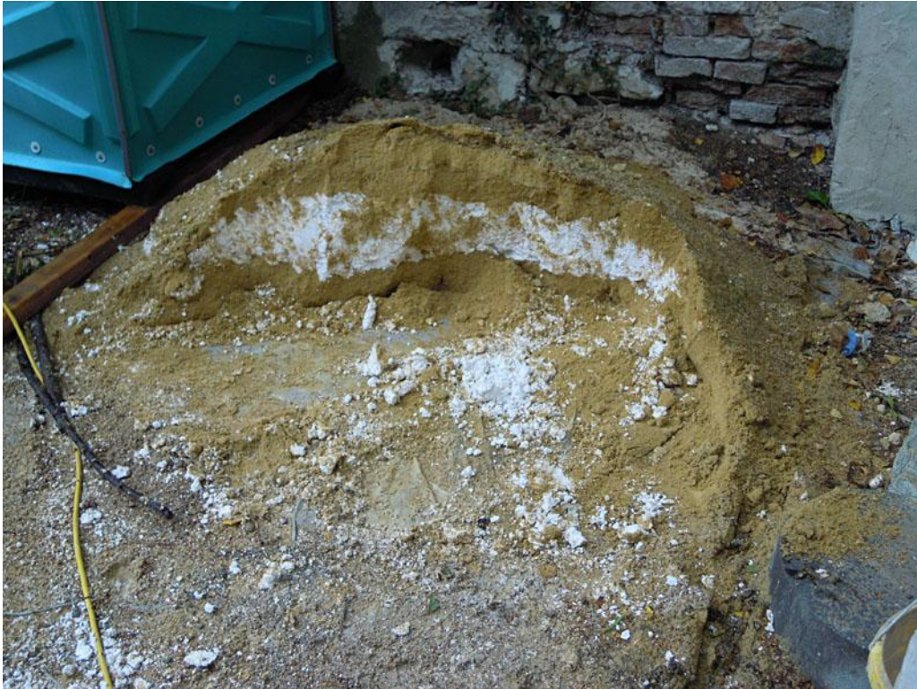
Angestochener, Trockengelöschter Kalkmörtel. Foto: S. Pichler
